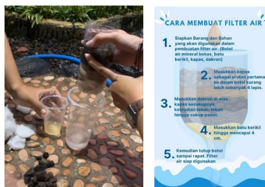
Gambar 3 Proses pembuatan filter air
